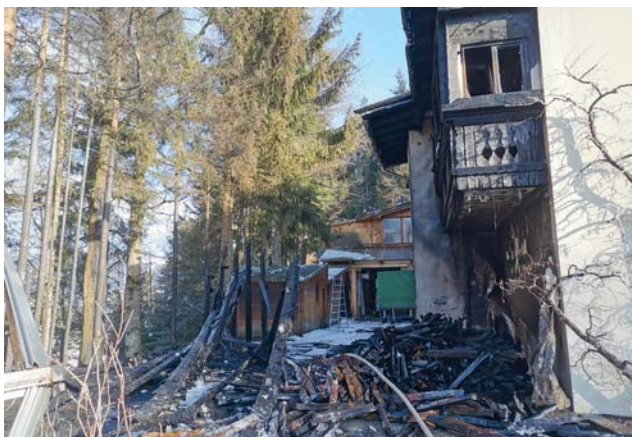
Bei einem Brand wurde die Unterkunft einer Glaubensgemeinschaft in Auffach zerstört. Die FF Söll unterstützte die Nachlöscharbeiten.
