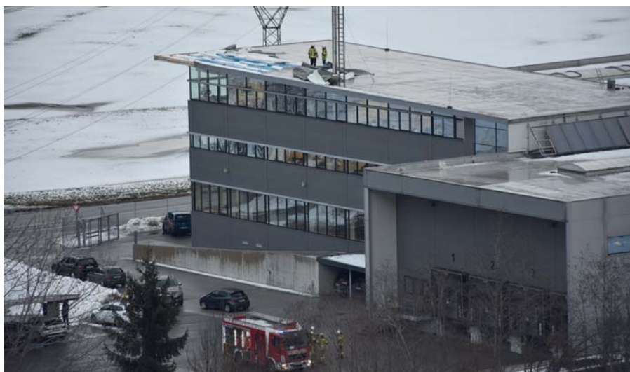
Windeinsatz im Februar 2020 bei einem Söller Industriebetrieb
